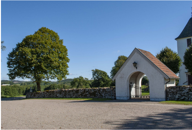
Stigluckan och muren mot väster.
