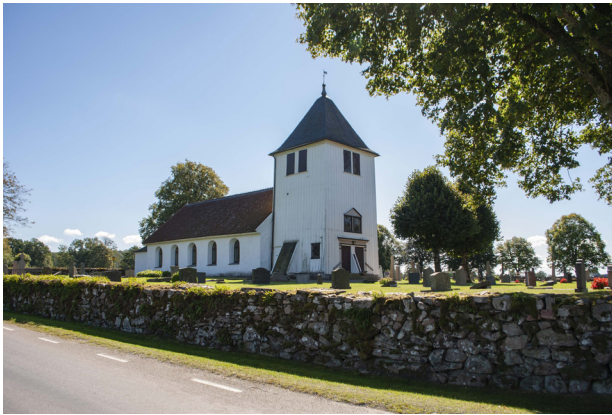
Mot landsvägen i norr bildar muren en hög stödmur.
