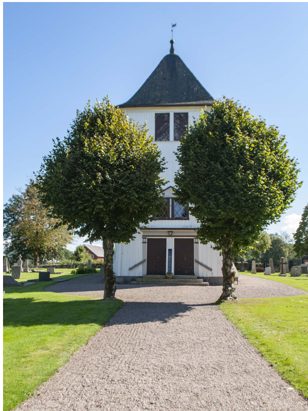
Den äldre delen av kyrkogården delas in i två kvarter genom en grusad mittgång med kyrkan i mitten. Närmast tornet står två hamlade lindar.
